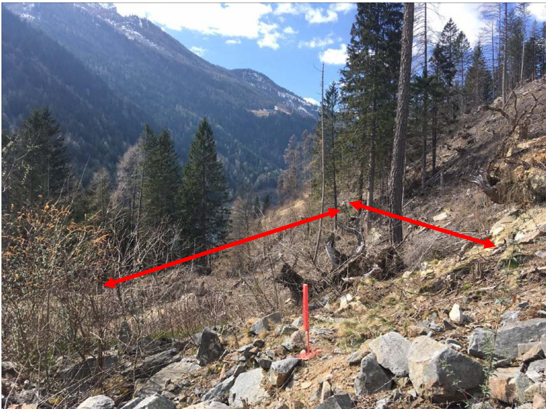
Bereich des geplanten Werks/Deponie.
